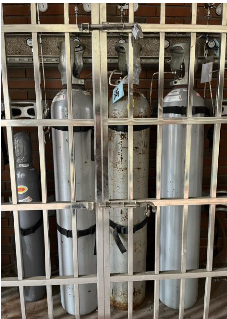
▲圖2 高壓氣體鋼瓶固定
