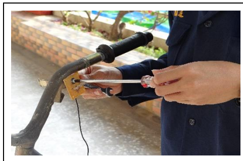
圖 4-16：感知器指示燈號安裝
