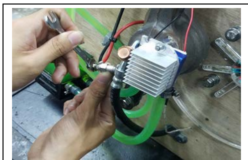
圖 6-11 安裝柴油預熱塞
