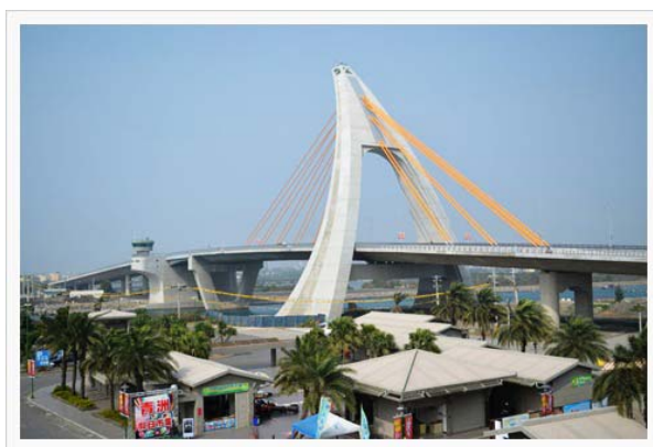
圖 3 大鵬灣跨海大橋
