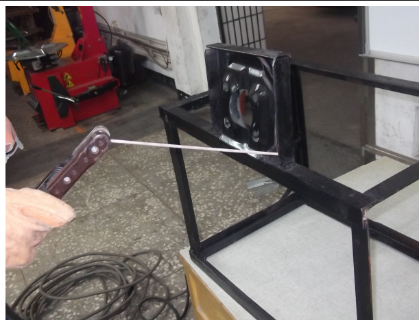
圖11 焊接真空被力器固定支架
