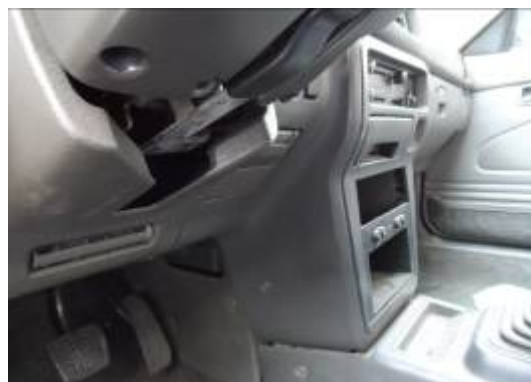
(圖4-6) 架設滅火器鋼索到車內拉柄
