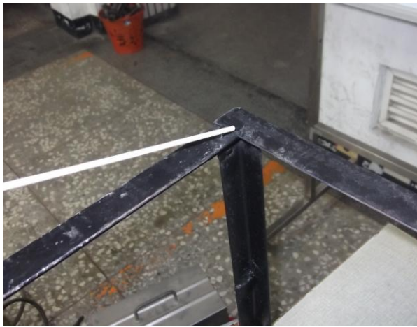
圖10 焊接固定煞車踏板及真空被力器腳架
