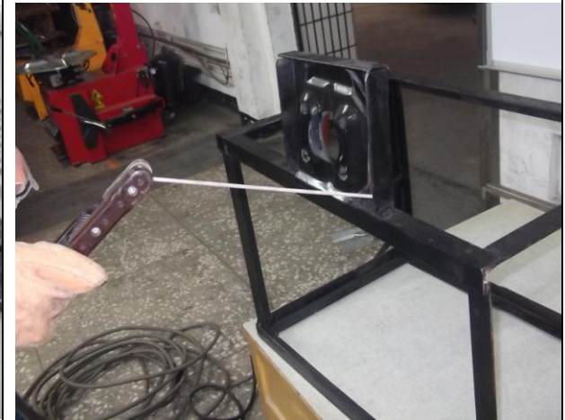
圖11 焊接真空被力器固定支架
