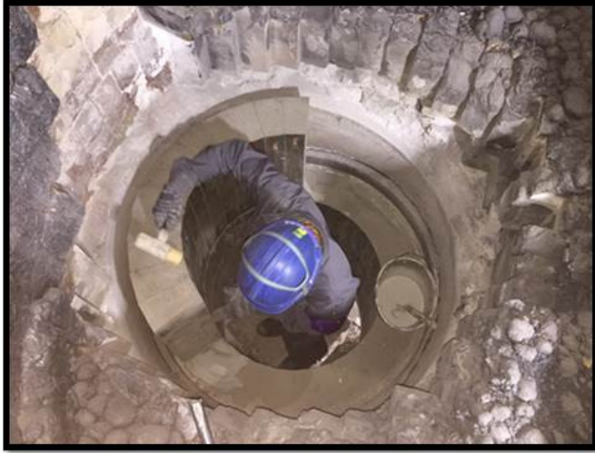
(圖十三) 工程實績(煉鋼廠設備)-維修砌磚作業 1
