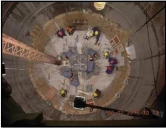
(圖五) 工程實績(煉鋼廠轉爐)-轉爐爐視砌築
