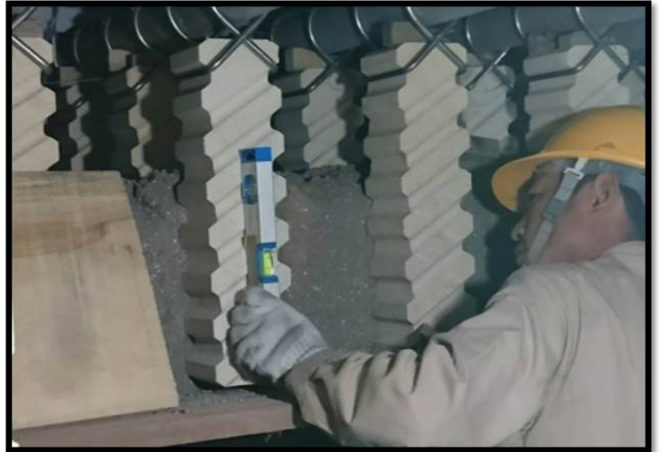
(圖十六) 工程實績(軋鋼廠加熱爐)-加熱爐爐頂吊磚及搗固作業
