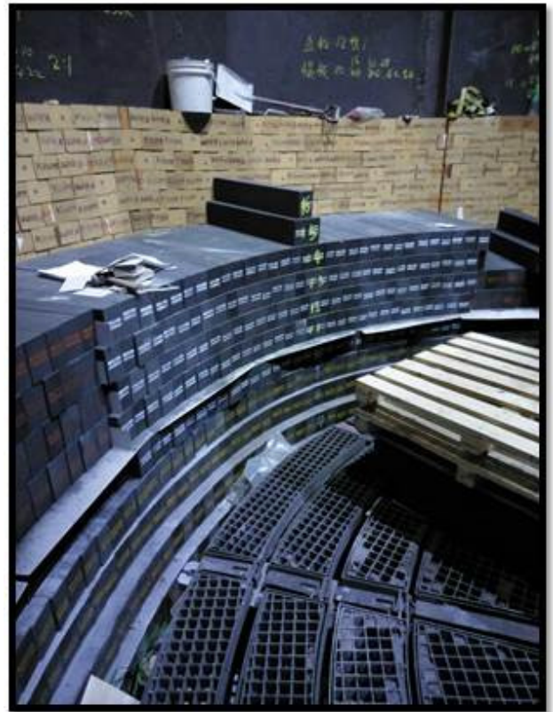
(圖六) 工程實績(煉鋼廠轉爐)-轉爐壁磚砌築
