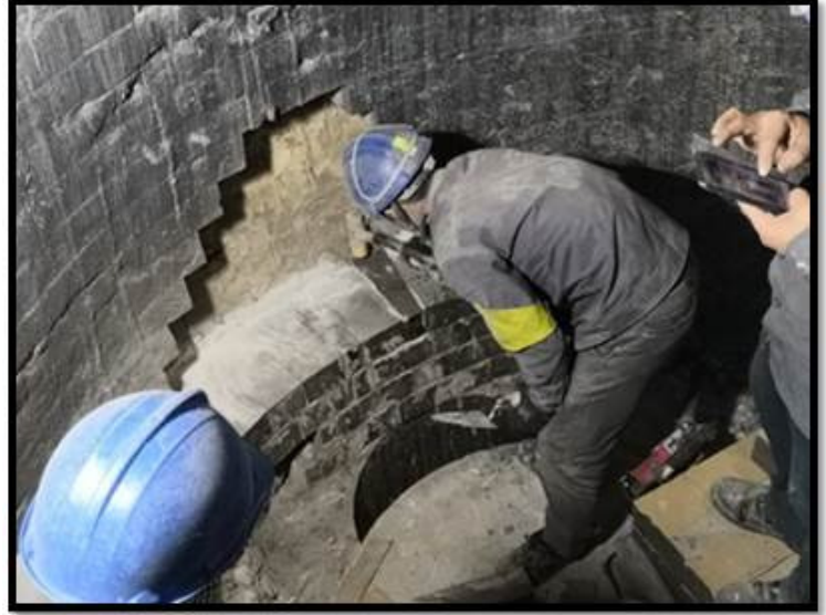
(圖十六) 工程實績(軋鋼廠加熱爐)-加熱爐爐頂吊磚及搗固作業
