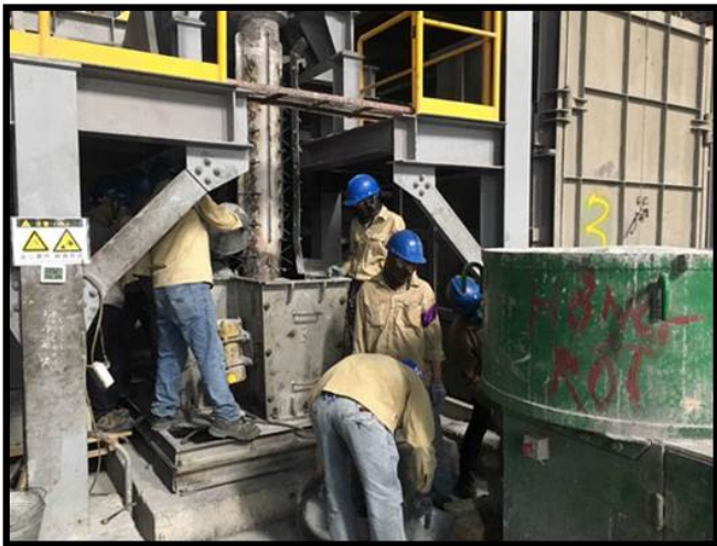
(圖七) 工程實績(煉鋼廠設備)-轉爐 KR 攪拌器組模灌漿
