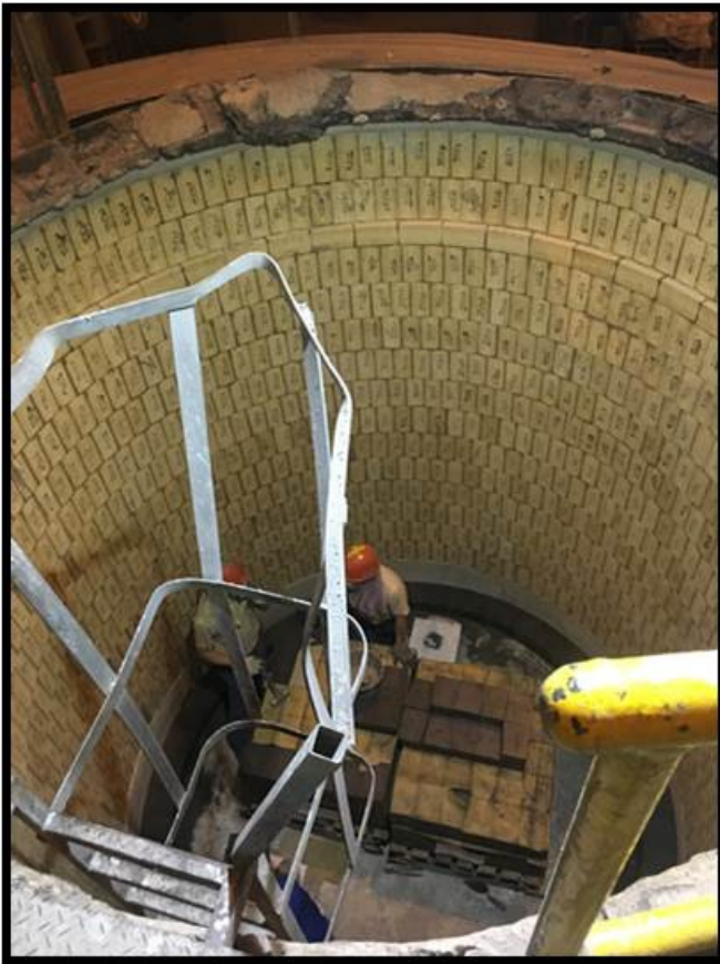
(圖十一) 工程實績(煉鋼廠設備)-煉鋼廠盛鋼桶砌磚作業
