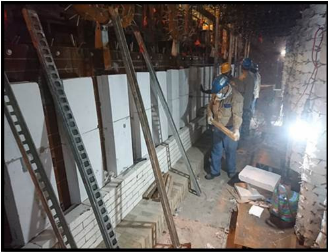
(圖十五) 工程實績(軋鋼廠加熱爐)-加熱爐爐壁施工狀況
