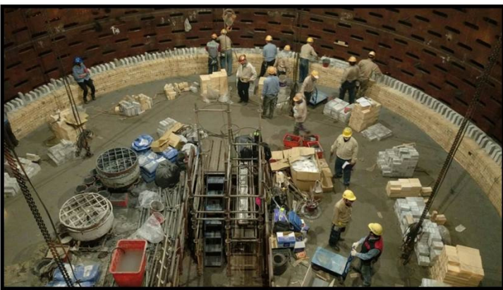
(圖三) 工程實績(煉鐵高爐)-高爐冷卻室耐火磚砌築
