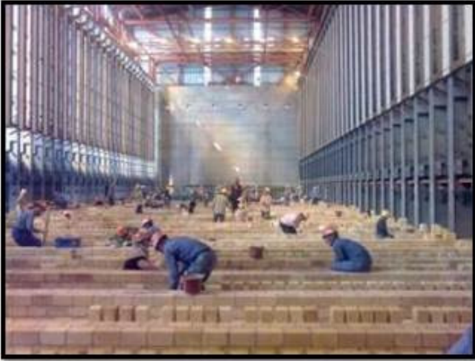
(圖一) 工程實績(煉焦設備)-新建煉焦爐砌築中
