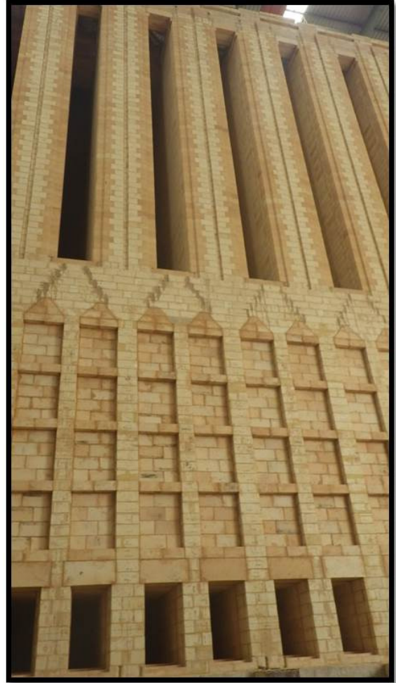
(圖二) 工程實績(煉焦設備)-煉焦爐砌築完成後外觀
